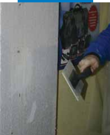
Dobijanie płyty styropianowej podczas instalacji
